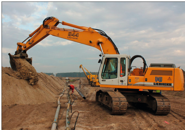
Umverlegen einer Trinkwasserleitung.
