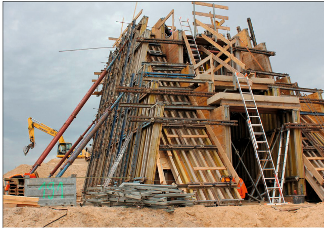
Schalung für das Brückenwiderlager Bauwerk 14.
