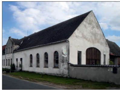
Ehemaliger Gasthof, Mitte des 19. Jahrhunderts erbaut
