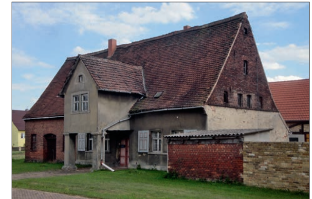
Einzig erhaltenes Laubenhaus der Region, Ende 18. Jahrhundert erbaut
