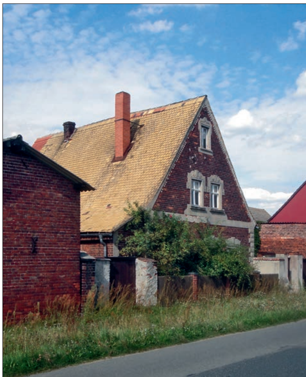
Giebelständiges Bauernhaus mit Putzdetails in Jugendstilformen
