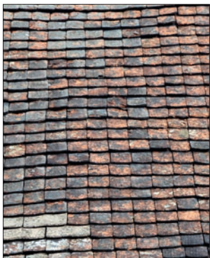
Dach mit Biberschwanziegeln
