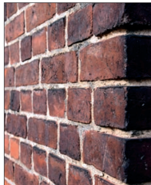
Ziegelfassade mit Läufern und Bindern
