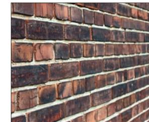
Typische Ziegelfassade mit Läufern und Bindern
