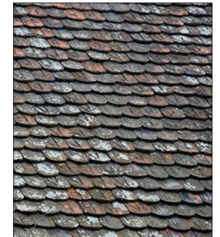
Dach mit Biberschwanzziegeln
