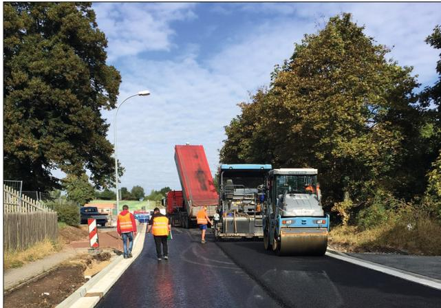
Einbau Binderschicht Ortsausgang Thale in Richtung Kreisverkehr Timmenrode/Warnstedt.
