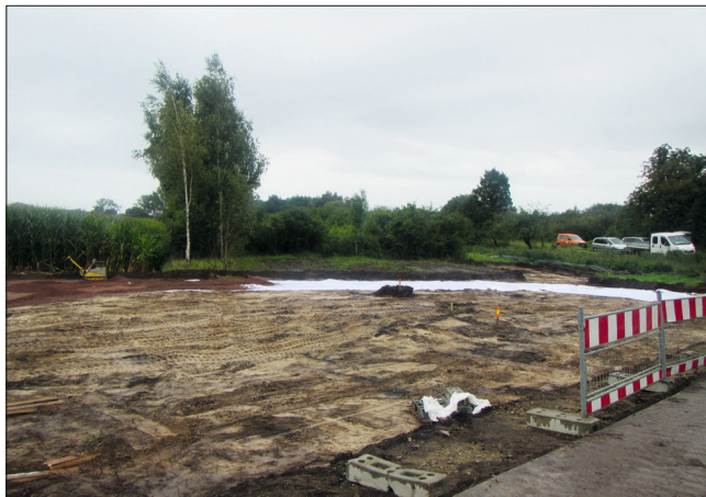
Vorbereitung der Baustraße im Bereich des Bauwerks 01A durch die Landesstraßenbaubehörde Sachsen-Anhalt.
