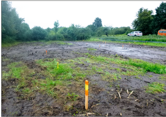
Baufeldfreimachung im Bereich von Bauwerk 01A im Zuge der Vorbereitungen zur B188 Ortsumgehung Oebisfelde.
