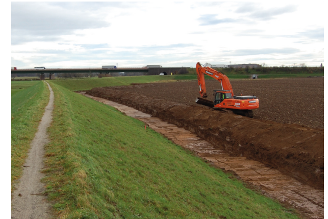
Archäologische Dokumentationen (hier: maschineller Oberbodenabtrag) im Bereich des Gatzter Bergdeichs. Im Hintergrund ist die A9 erkennbar.
