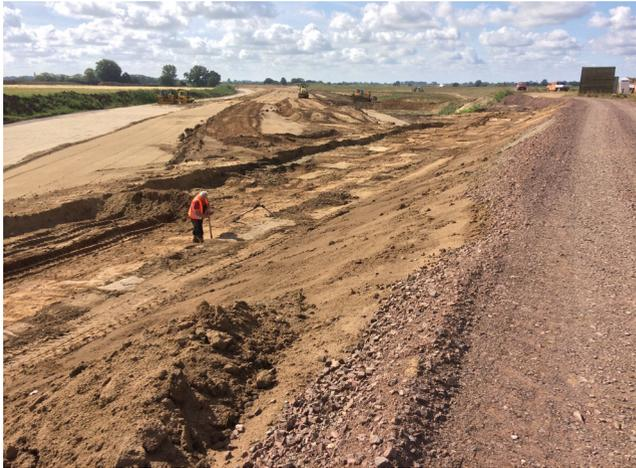
Auf der alten und neuen Deichtrasse wird im Vorfeld der Ausgrabung die Kampfmittelsondierung durchgeführt.
