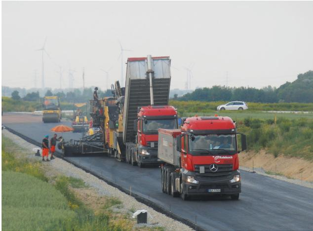
Kompaktasphalteinbau mittels Modulfertiger.
