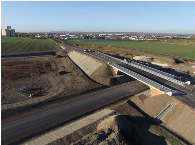
Straßenneubau der B 79n nach Halberstadt, Oktober 2018, Blick Richtung Nordwesten.
