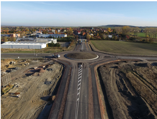
Straßenneubau der B 79n nach Harsleben, Abzweig Westerhausen, Oktober 2018, Blick Richtung Südosten.
