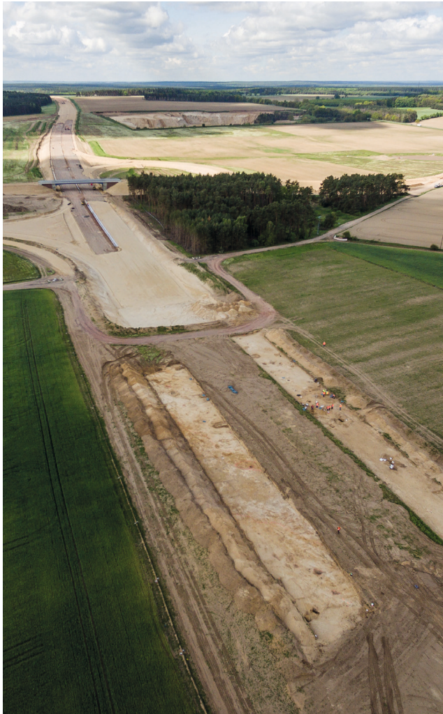
Blick auf die Neubautrasse bei Dolle im Mai 2019 (Blick in Richtung Norden). Im vorderen Bildbereich liegt die Ausgrabungsfläche (früheisenzeitliches Gräberfeld). Im Mittelbereich des Fotos erfolgen bereits vorbereitende Maßnahmen für den Straßenbau.
