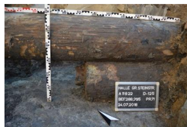
Abb. 6: Die untere um 1600 errichtete Holzwasserleitung wurde mit einem Pfropfen verschlossen, und durch eine jüngere, direkt darüber verlegte Holzwasserleitung nach 1819 ersetzt.
