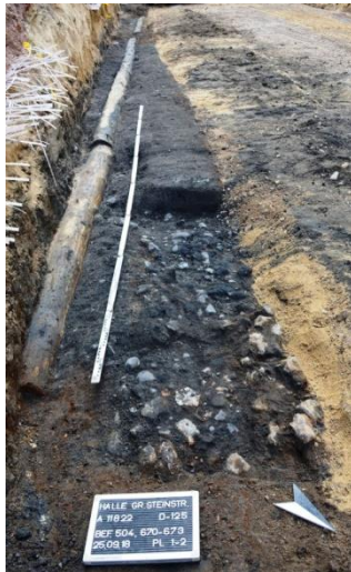
Abb. 7: Holzwasserleitung am Südrand der Großen Steinstraße zwischen dem Joliot-Curie-Platz und der Schimmelstraße. Der über 20 m Länge verfolgte Leitungsteil in der Großen Steinstraße wurde um 1600 n. Chr. verlegt und durchstößt ältere Pflasterun- gen. © Landesamt für Denkmal- pflege und Archäologie Sachsen- Anhalt, Foto: M. Scheunchen
