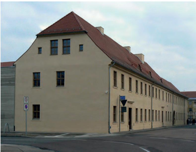
August Fleischhauer; Gesamtinstandsetzung, dabei Rückbau der einsturzgefährdeten Giebel und Erneuerung des sehr schadhaften Dachstuhls; Rekonstruktion der Giebel nach steingenaum Aufmaß, Wiederverwendung erhaltener Teile der vorher mit Zementmörtel überputzten Fenstergewände, Schutzverdachung für die historische Gedenkplatte aus Sandstein
