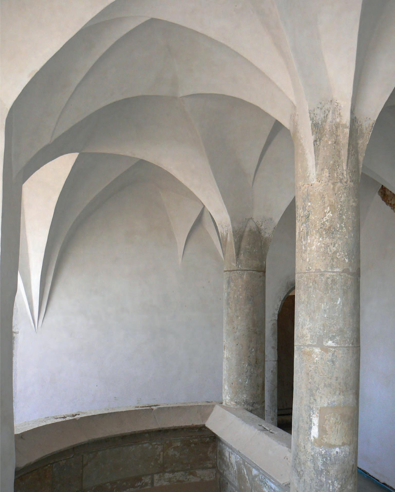
chen Zementputzes, Reparatur der Sandsteingewände
