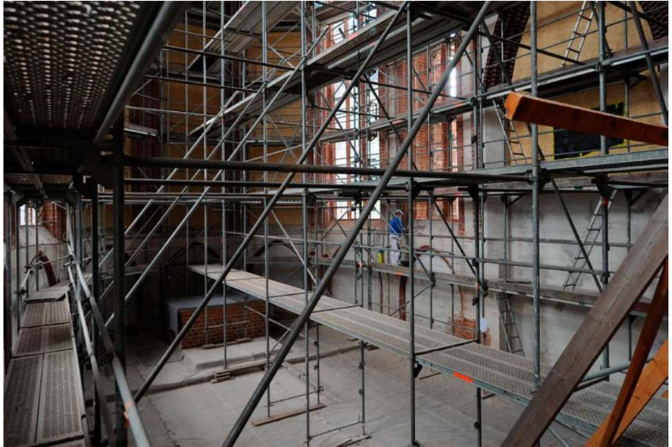
Westturm ist durch jüngere Anbauten in den Kirchenbau gerückt. Abstimmung des Konzepts für die statische Sanierung des Polygonchores; restauratorische Befunduntersuchung, mauerermäßige Instandsetzung innen und außen sowie farbliche Neufassung des Chorraums nach den Untersuchungsergebnissen
