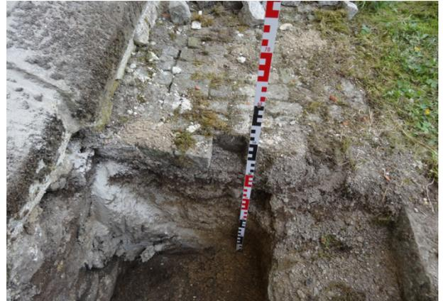
*Schürfe mit freigelegter Vertikalsperre auf Tonbasis: falscher Einbau dieser führt zur „Bewässerung“ des Fundaments durch Schichtenwasser*
