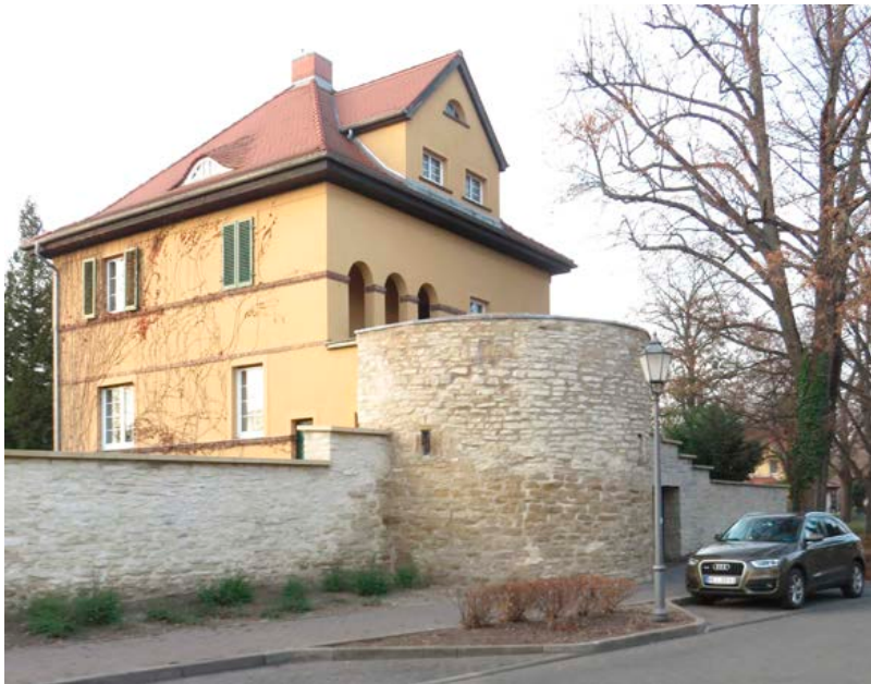
BERNBURG (SAALE), SALZ- LANDKREIS, STADTMAUER IM BEREICH DES GOETHEWEGES
