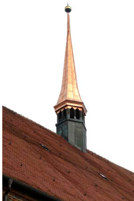
HANSESTADT STENDAL, ST. MARIEN, RESTAURIERTER DACHREITER
