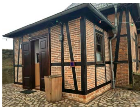
FALKENSTEIN (HARZ), OT PANSFELDE, LKR. HARZ, BURG FALKENSTEIN, FACHWERKVORBAU DES "KRUMMEN TORS" DER VORBURG (LINKS), DREHPFOSSENTOR DES SÜDZWINGERS (RECHTS)
