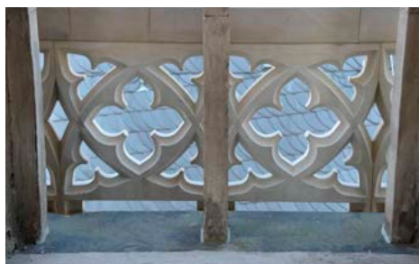
HALLE (SAALE), ST. ELISABETH UND ST. FRANZISKUS, MASSWERKBRÜSTUNG AM UNTEREN TURMUMGANG
