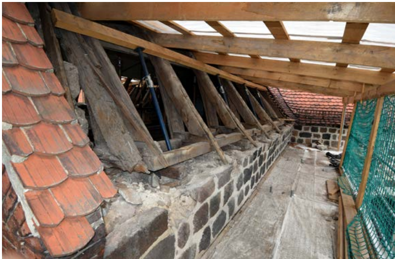
BURG, LKR. JERICOWER LAND, ST. NIKOLAI, DACHWERK DES QUERSCHIFFS
