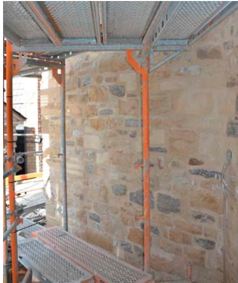
GEGENÜBERLIEGENDE SEITE: HALLE (SAALE), VILLA AUGUST- BEBEL-STRASSE 48A, TREPPEN- HAUS (OBEN) PFERDESTALL DER BRAUEREI BÖLLBERGER WEG 168 (UNTEN)
