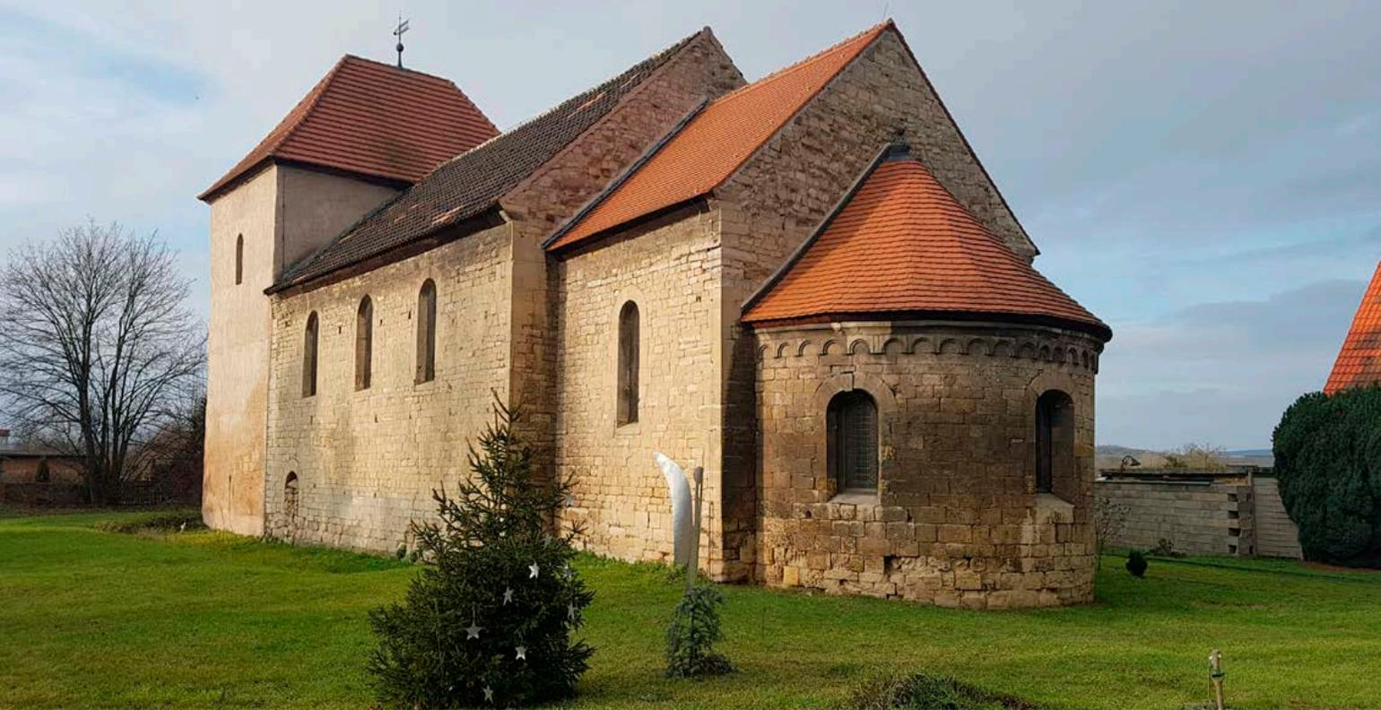
Neuersatz der Mauersteine waren nur teilweise notwendig, vor allem in den unteren Bereichen. Der von dem seit Jahrhunderten angewachsenen Erdreich verdeckte Sockel mit Platte und Schräge wurde freigelegt und dokumentiert. Nach den auch dort durchgeführten Sicherungsmaßnahmen wurde die Horizonthöhe wiederhergestellt.
