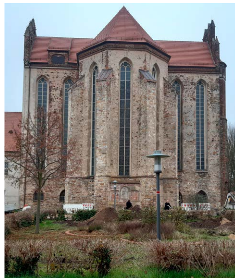
HANSESTADT HAVELBERG, LKR. STENDAL, DOMPLATZ 3, DOM ST. MARIEN VON OSTEN MIT NEU EINGEDECKTEM BZW. SANIERTEM DACH
