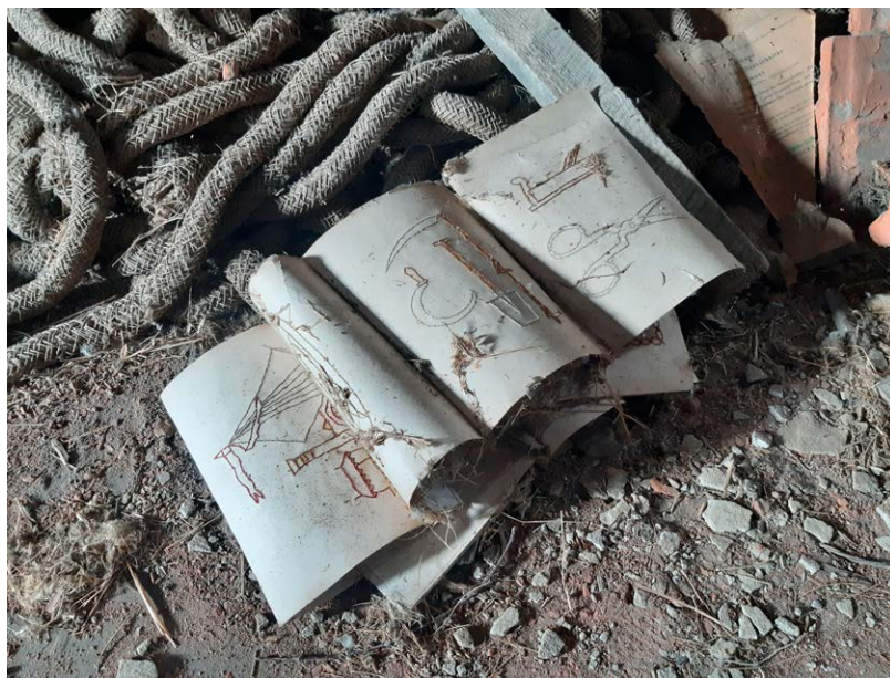
ORANIENBAUM-WÖRLITZ, OT VOCKERODE, LKR. WITTENBERG, WALDERSEER STRASSE 2, DACHBODEN DES BAUERNHAUSES VOR INSTANDSETZUNG MIT FUNDSTÜCK EINES STICK-MUSTERBUCHES
