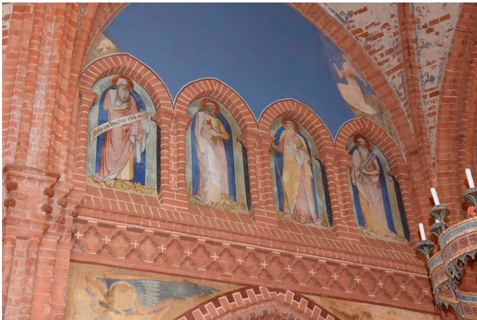
HANSESTADT STENDAL, OT VOLLENSCHIER, LKR. STENDAL, ZUR KIRCHE, GUTSKIRCHE, WANDMALEREI WÄHREND DER KONSERVIERUNG
