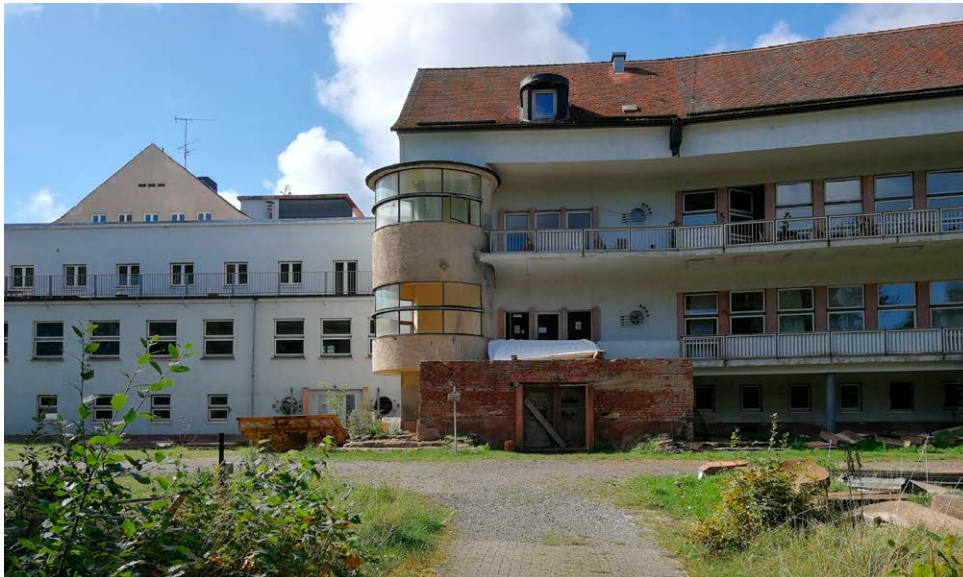
HARZGERODE, LKR. HARZ, FREIE FELDLAGE 9, EHEM. KIN- DERLUNKENKLINIK, FREITREP- PE AN DER OSTSEITE IN SANIE- RUNG
