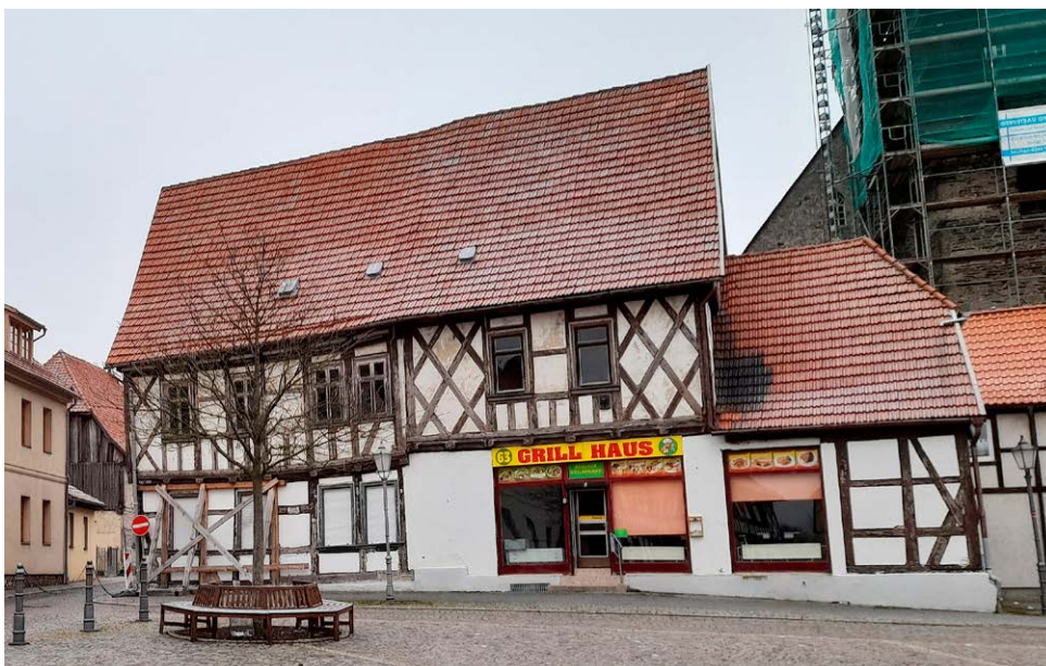
HARZGERODE, LKR. HARZ, MARKTPLATZ 5, BERGFAKTOREI VOR SANIERUNG
