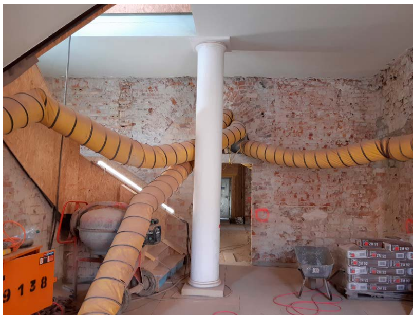
DESSAU-ROSSLAU, ZERBSTER STRASSE 35, PALAIS DIETRICH LINKS/RECHTS: DENKMALPFLEGERISCH BEGLEITETE BAUARBEITEN UNTEN: TORBOGEN MIT FIGUREN
