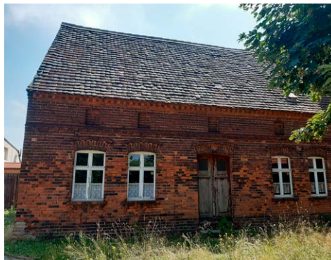
ORANIENBAUM-WÖRLITZ, OT GRIESEN, LKR. WITTENBERG, AN DER TRÄNKE 10, EHEM. TAGELÖHNERHAUS STRASSEN- UND HOFSEITIG
