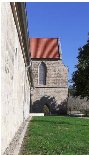
WELTERBESTADT QUEDLINBURG, LKR. HARZ, WIPERTISTRASSE 5, ST. WIPERTIKLOSTER UNTEN: BLICK AUF DEN CHORALTAN VON SÜDEN RECHTS: ERDGESCHOSSAAL NACH DER SICHERUNG
