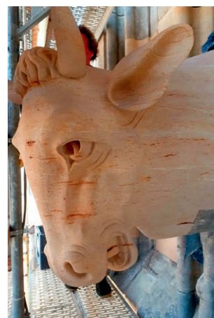
MAGDEBURG, DOM, NORD- QUERHAUS OBEN RECHTS: REKONSTRUIERTE KREUZBLUME UNTEN RECHTS: KUHWASSERSPEIER MIT ERGÄNZTEM KOPF
