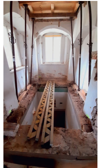
GOSECK, BURGENLANDKREIS, SCHLOSS, NORDFLÜGEL, SICHERUNGEN IM 1. OG DES ERKERS
