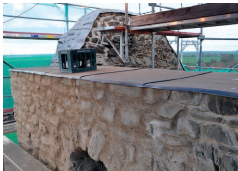
HALDENSLEBEN, OT HUNDISBURG, LKR. BÖRDE, WÜSTUNG NORDHUSEN, KIRCHENRUINE MIT BAUSTELLENSITUATION (UNTEN) UND DETAIL DER MAUERKRONE WÄHREND DER INSTANDSETZUNG MIT ABDECKUNG AUS WALZBLEI (LINKS)
