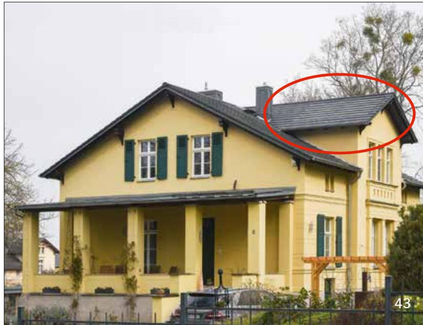
**Abb. 43** Naumburg, Villa, farblich angepasste, kleinformatische Indach-Solarmodule
