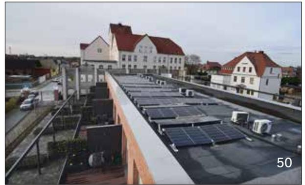
**Abb. 49–50** Burg, hinter einer baulich bedingten Sichtbarriere (Attika) montierte, aus dem öffentlichen Raum nicht einsehbare PV-Module
