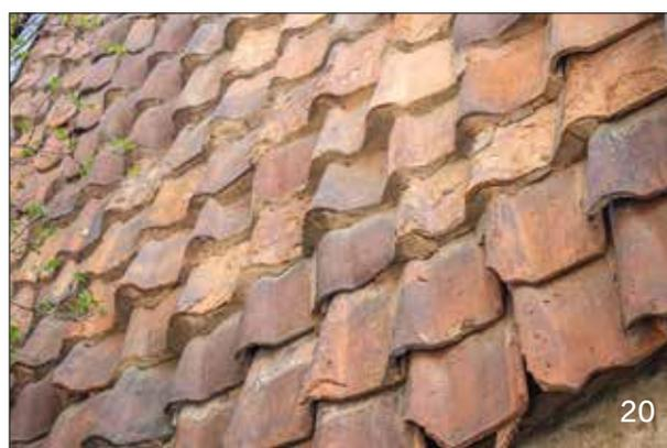
**Abb. 16–17** Quedlinburg, Neueindeckung mit Biberschwanzziegeln, teilweise in Sekundärverwendung
