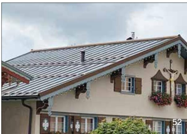
**Abb. 52** Weiler-Simmerberg, Wohnhaus, im Bereich des Firstes sind Dünnschichtmodule in Form von Solarfolien auf dem Dach mit Stehfalzeindeckung aufgebracht
