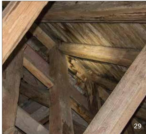
**Abb. 29** Aschersleben, St. Stephani, Dachstuhl vor der Instandsetzung, Feuchtigkeitsschäden durch undichte Deckung, nachfolgend Gefährdung des Dachwerks und des Gebäudes mit den Cranach-Tafelbildern
