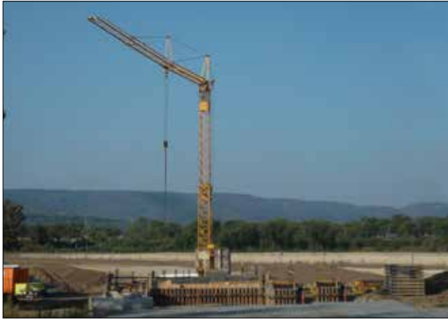
Neubau der Brücke über den Quarmbach.
