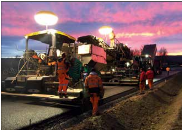
Asphalteinbau im Zuge des Neubaus der Strecke.
