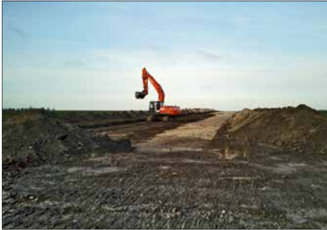
Baggerarbeiten im Trassenbereich der Ortsumgebung Halberstadt-Harsleben.
