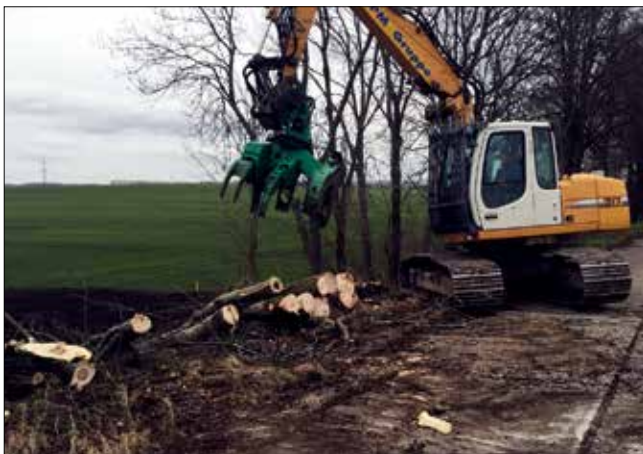
Baumfällarbeiten in Vorbereitung für den Straßenbau.
